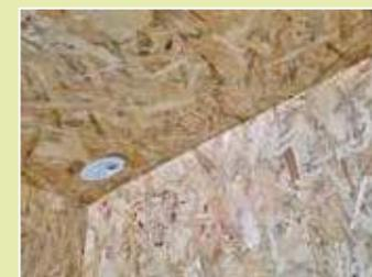
Finition intérieure avec plafond en OSB3 et grilles de ventilation
