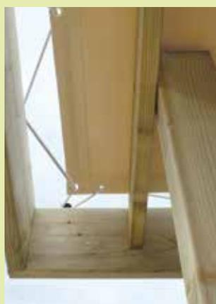
Charpente avec débord de 23 cm de chaque côté + fixation par sandow, poulies et rail arrière avec bavette d'étanchéité intégrée
