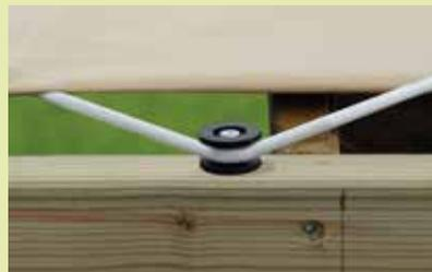
Charpente avec débord de 23 cm de chaque côté + fixation par sandow, poulies et rail arrière avec bavette d'étanchéité intégrée
